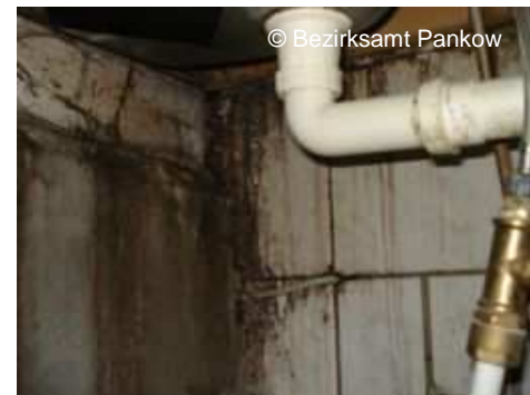
Bild 6: Bereich unterhalb der Spüle
